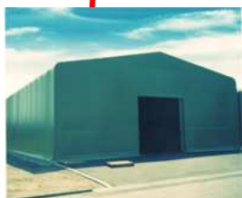
テント倉庫・屋根工事
