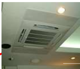
エアコン設置工事
