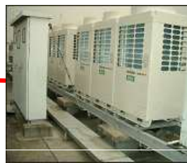
空調設備工事
